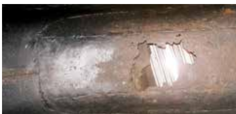
Det är rejäla hål i reservhjulsbaljorna på både sidor om motorn
