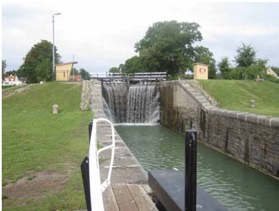
Bergs slussar strax utanför Linköping, sju slussar i rad för att lyfta/sänka båtarna
